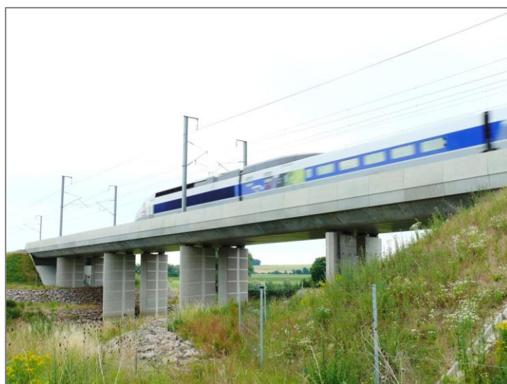
Figure 56 - Le viaduc LGV de la Seille à Cheminot. (Source : https://structurae.net/fr/medias/114248-lgv-est-europeenne-viaduc-de-la-seille )
