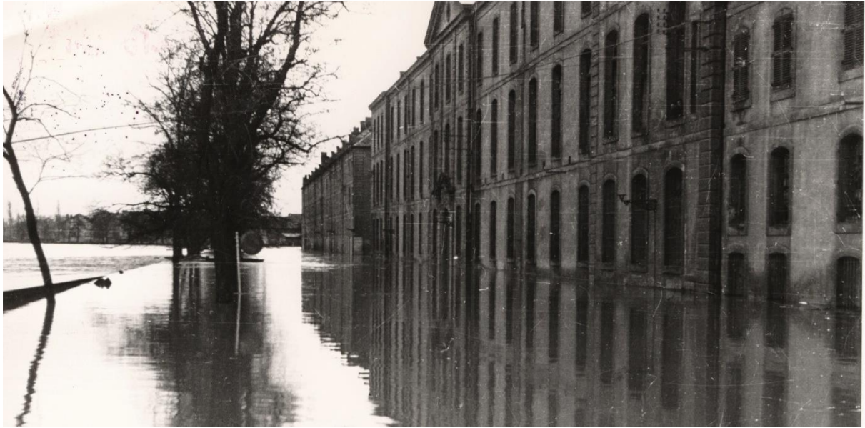
Figure 20 : Quai Wiltzer sous les eaux en janvier 1948 (BD Carmen)
