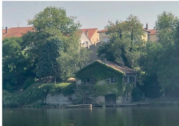
Figure 8 : Moulin de Malroy entre Metz et Thionville. (Syndicat Mixte Moselle Aval© -24/07/2018)
