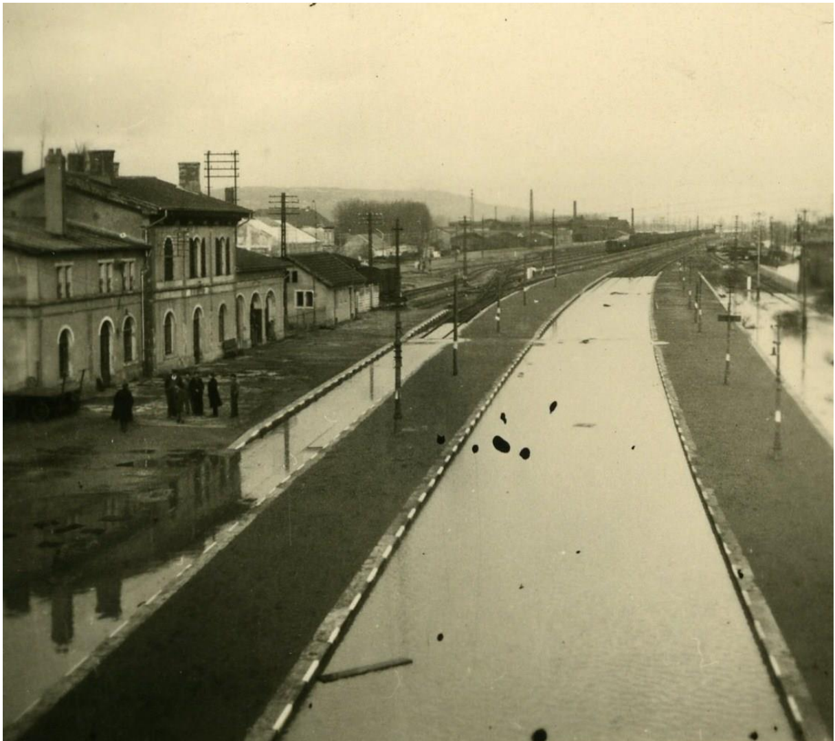
Figure 21 : Voies de chemin de fer à la hauteur de la gare de Ars-sur-Moselle sous les eaux (source : archives municipales d'Ars-sur-Moselle)
