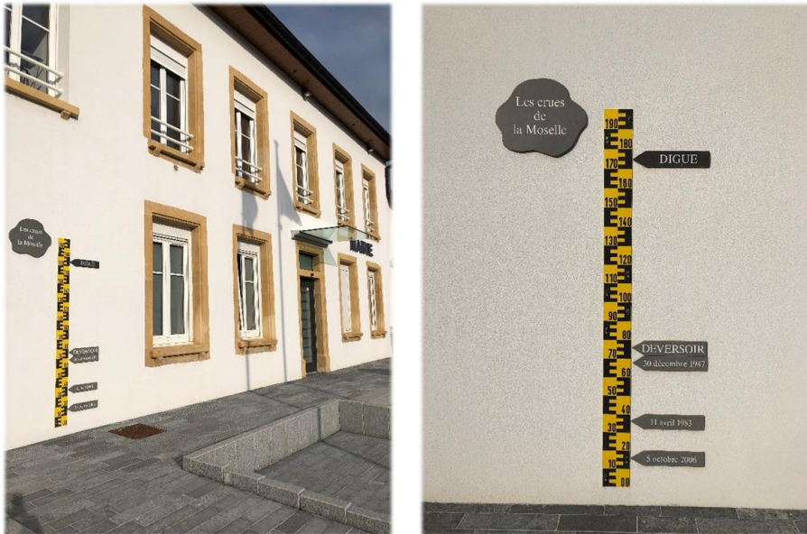
Figure 47 : Repères de crue sur la Mairie de Hauconcourt en Moselle (Syndicat Mixte Moselle Aval© -04/12/2018)
