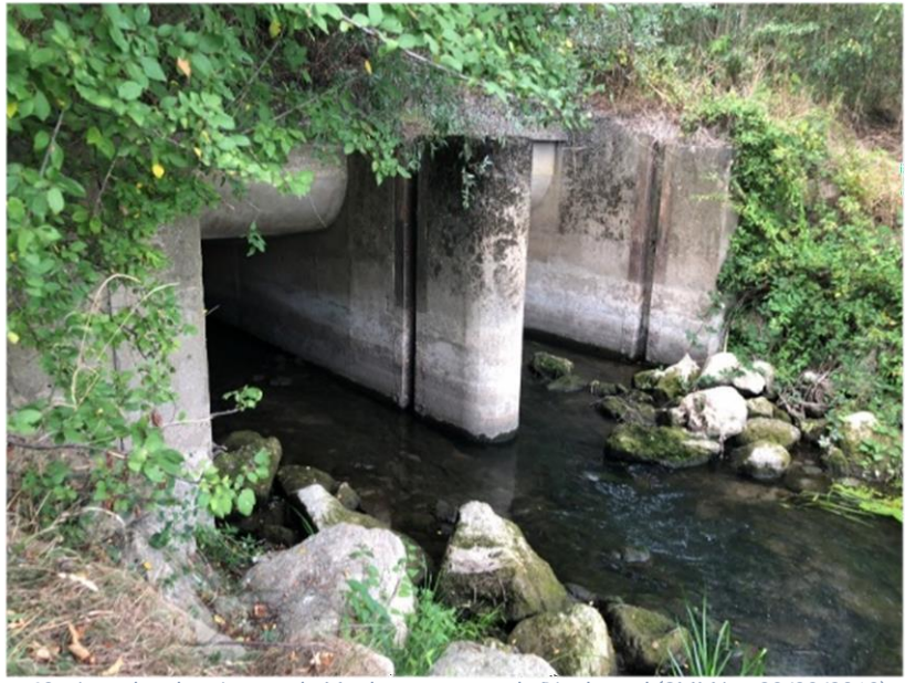
Figure 63 : Aqueduc du ruisseau du Moulon – secteur de Dieulouard (SMMA – 23/08/2018)
