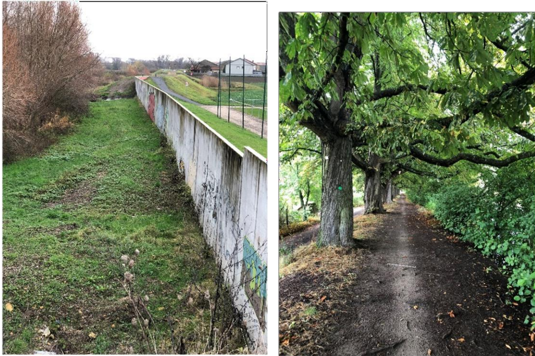
Figure 65 : Dignes de Hauconcourt et du Canal de Jouy (Syndicat Mixte Moselle Aval© - 04/12/2018 et 01/08/2018)
