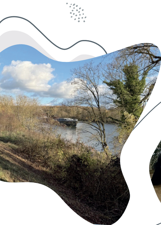
Entretien de la végétation herbacée sur la digue d'Ancy Ars-Sur-Moselle - Oct 2025
