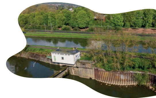
Rideau de palplanches défectueux qui sera remplacé courant 2026 au niveau de la digue de Ban Saint Martin
