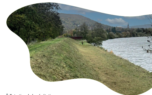
Entretien de la végétation herbacée sur la digue d'Ancy-Ars-Sur-Moselle - Oct 2025
