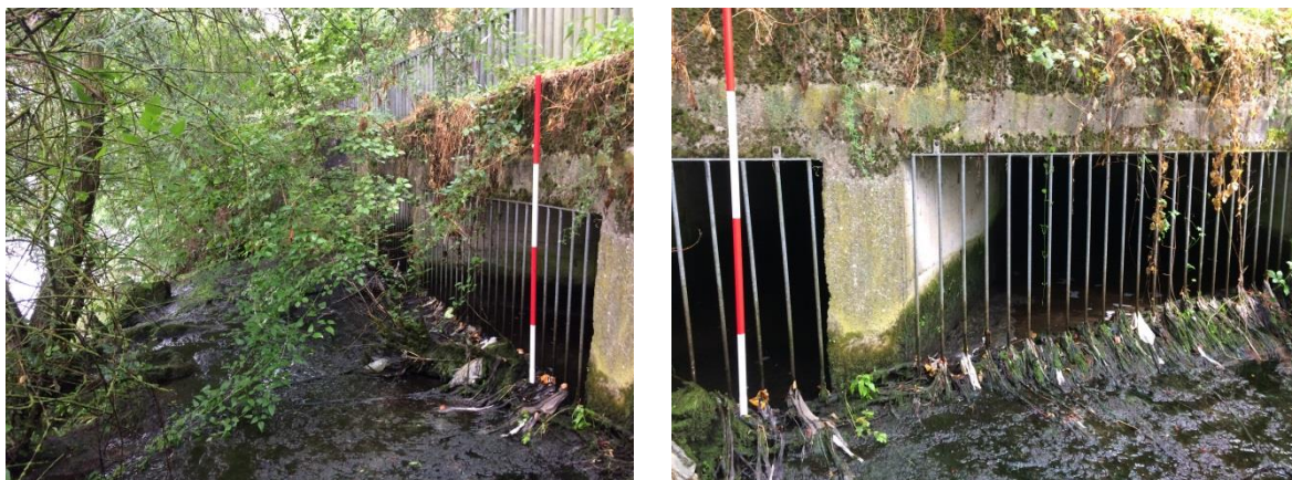
Figure 12 : Sortie des canalisations d'évacuation des eaux pluviales de la ZAE Actisud (Syndicat Mixte Moselle Aval© - 01/08/2018)
