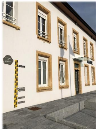
Repères de crue sur la Mairie de Hauconcourt en Moselle. (Syndicat Mixte Moselle Aval©- 04/12/2018)
